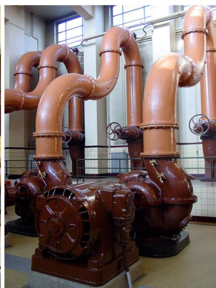
Photos 30 et 31 : Intérieur de la station de pompage principale n°6 de Seraing avec amorçage des pompes par le vide
