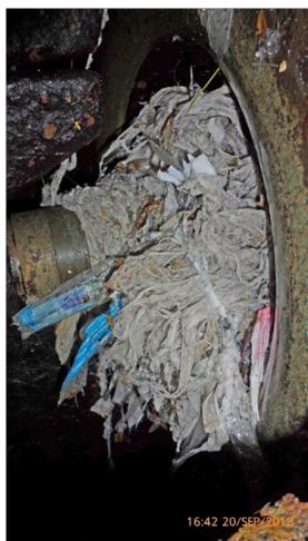
Photo 39 : Une des quatre pompes de la station de pompage principale n°6 de Seraing bouchées le 20 septembre 2018 par un afflux massif de lingettes occasionné par un orage important suivant une longue période de sécheresse. Ce sont les pompes de réserve qui ont alors empêcher l'inondation du fond de Seraing (AIDE).
